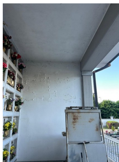
Degrado della parete dei loculi lungo il corridoio
